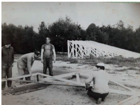
Vlevo: Kompletace střešní konstrukce, vpravo: Současně Sokolové stavěli i tenisové kurty
